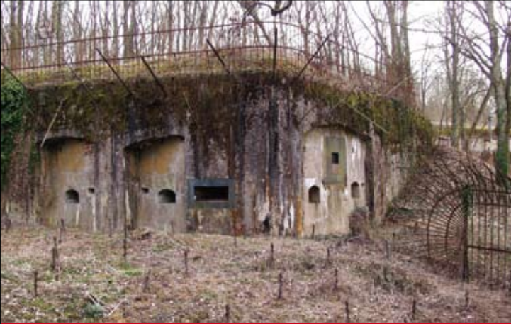
Das Infanteriewerk Avigy, die beiden Schartenfronten der Kehlkaponniere: Hinter den beiden rechteckigen, stahlumrandeten Scharten standen die Scheinwerfer. Im Vordergrund Reste des Drahthindernisses, rechts der linke Anschluss des Gittertores zum Stützpunkt Seille.
